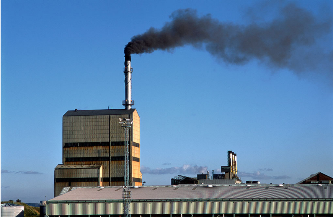
Contaminación provocada por una fábrica de papel. ©BELGA/RBR/SCIENCE
