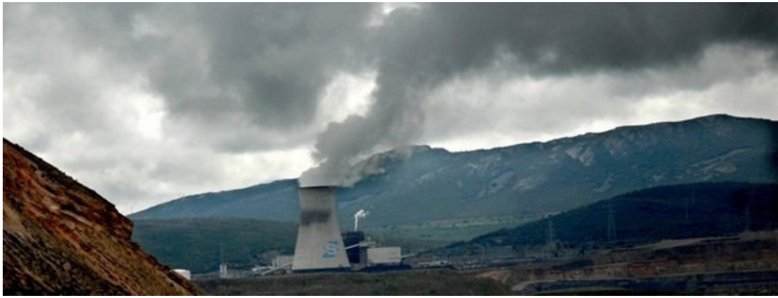
Imagen la central térmica de Puertollano Archivo
